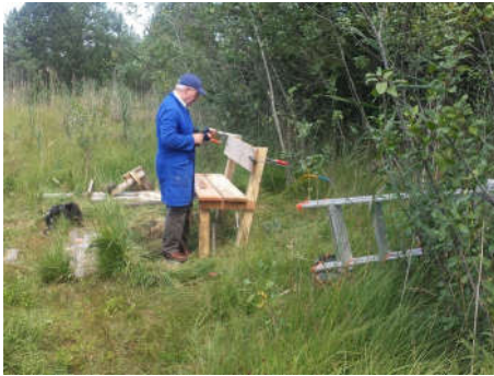
Reinhardt Renz montiert die neue Bank am Gröbensee
